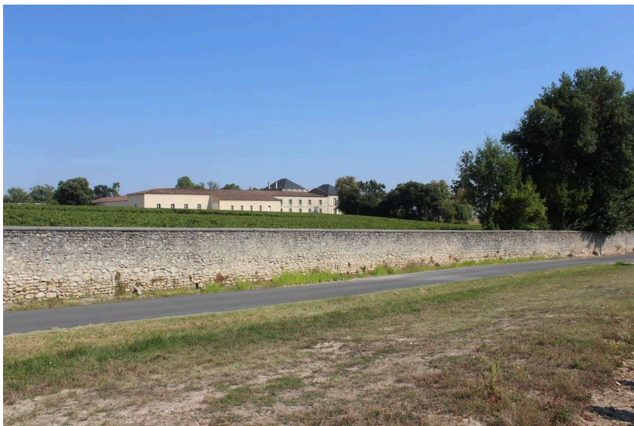
Mur de clôture au sud-ouest du château.
