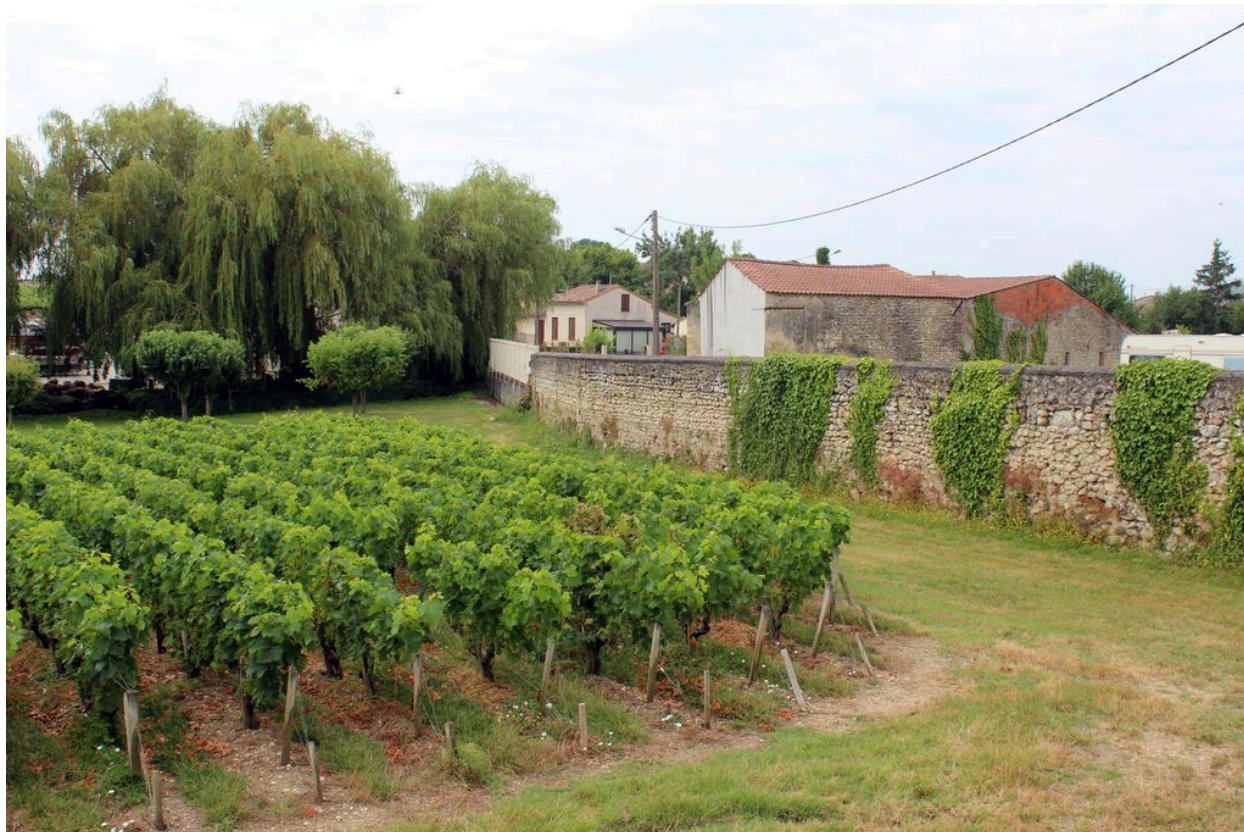
Mur de clôture au nord-ouest du château.
