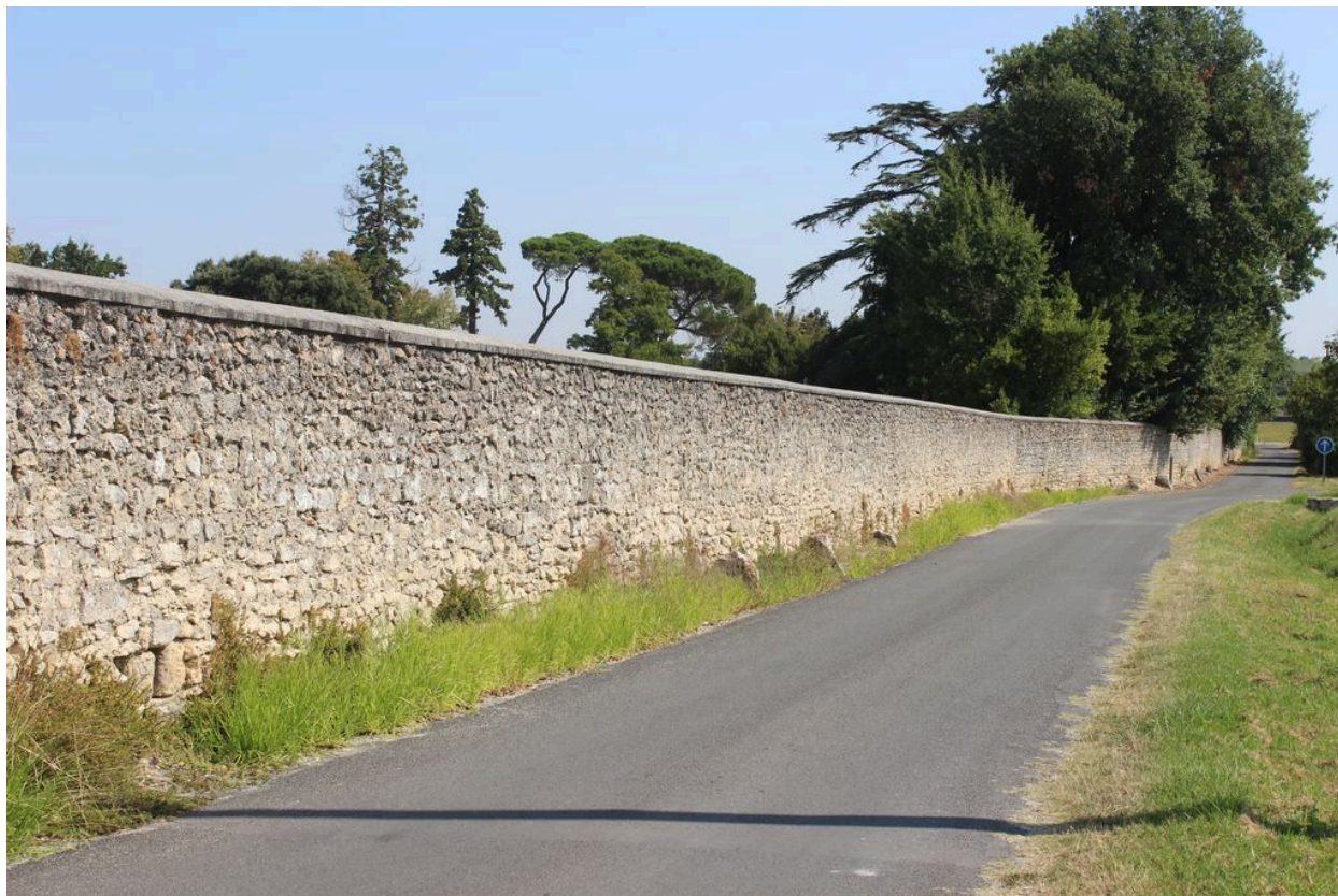
Mur de clôture au sud-ouest du château.
