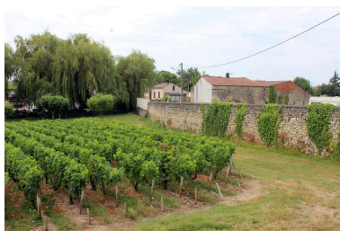
Mur de clôture au nord-ouest du château. Phot. Claire Steimer IVR72_20163302803NUC2A
