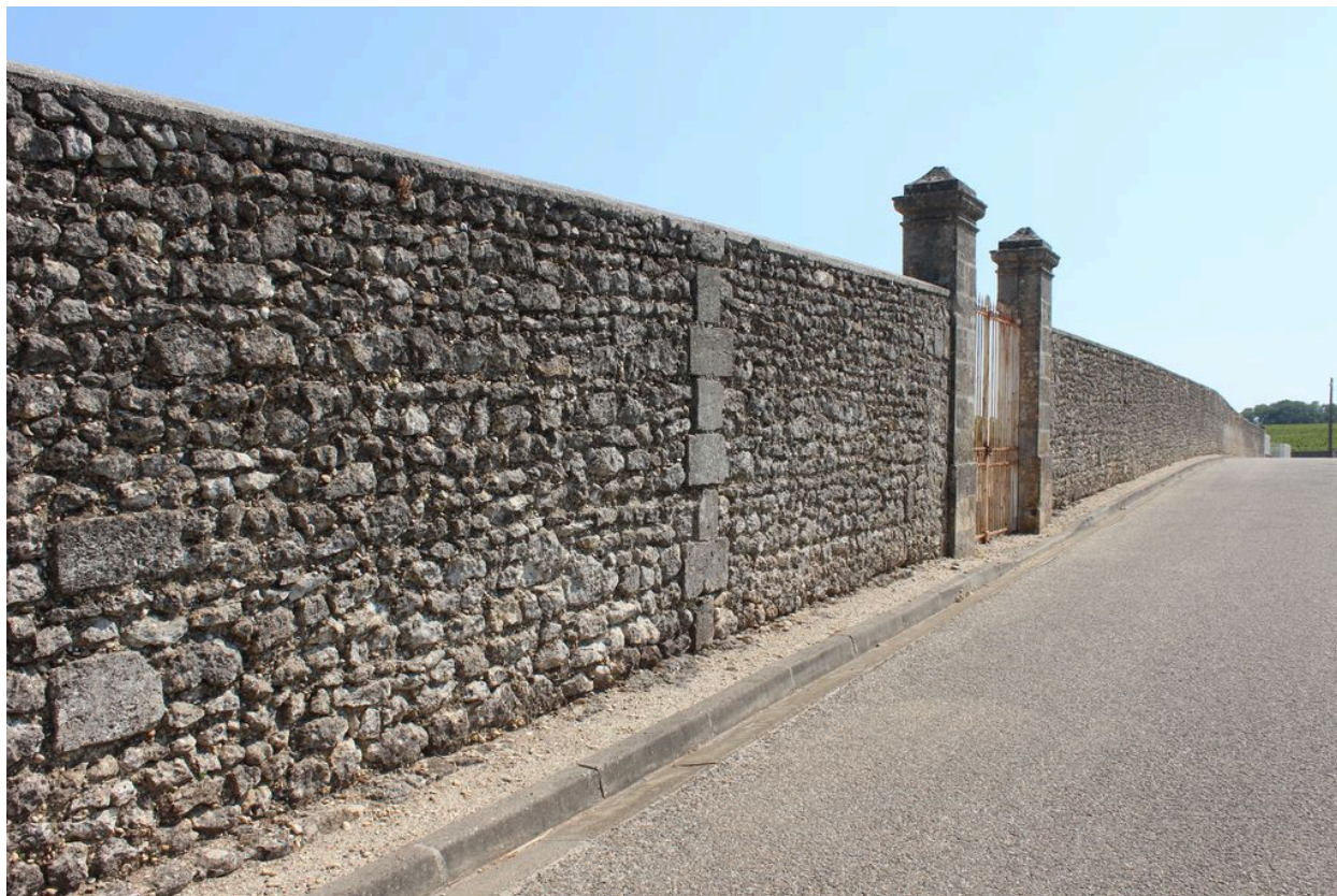
Mur de clôture à l'ouest du château avec portail à piliers maçonnés.
