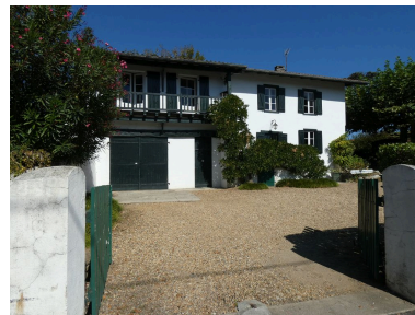
Vue de la façade principale et de la cour depuis le sud. Phot. Maïté Ehlinger IVR72_20196403269NUC2A
