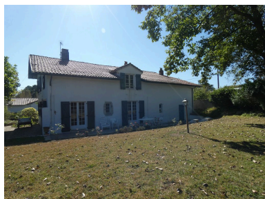
Vue d'ensemble depuis le nord. Phot. Maïté Ehlinger IVR72_20196403271NUC2A
