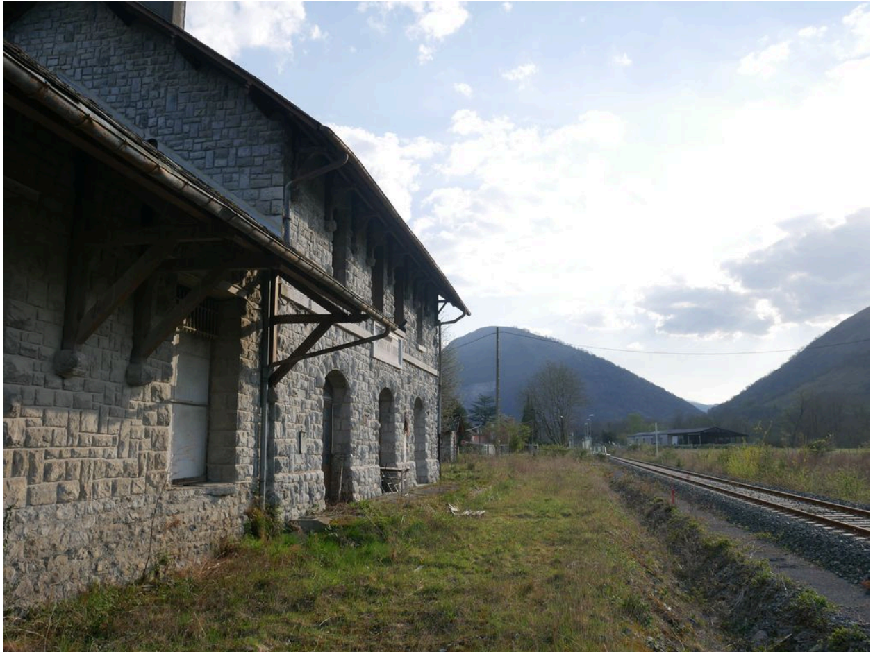
Gare de Saint-Christau-Lurbe. Bâtiment des voyageurs et voie ferrée.
