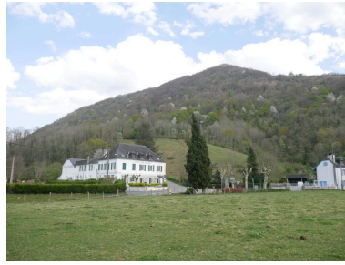
Hôtel des Vallées dans son environnement. Phot. Viviane Delpech IVR72_20196402312NUC2A
