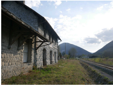
Gare de Saint-Christau-Lurbe. Bâtiment des voyageurs et voie ferrée. Phot. Viviane Delpech IVR72_20196402331NUC2A
