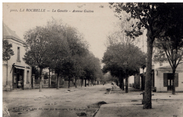
Carrefour des avenue Guiton et Coligny (carte postale ancienne). Repro. Claire Peyron IVR54_20051701810NUCA
