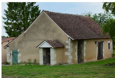
Grange et puits. Phot. Paul Maturi IVR75_20198604340NUCA
