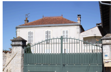
Une vue partielle du logement de l'ancienne ferme, depuis le sud-est. Phot. Nathalie Lhuissier IVR75_20191701995NUCA
