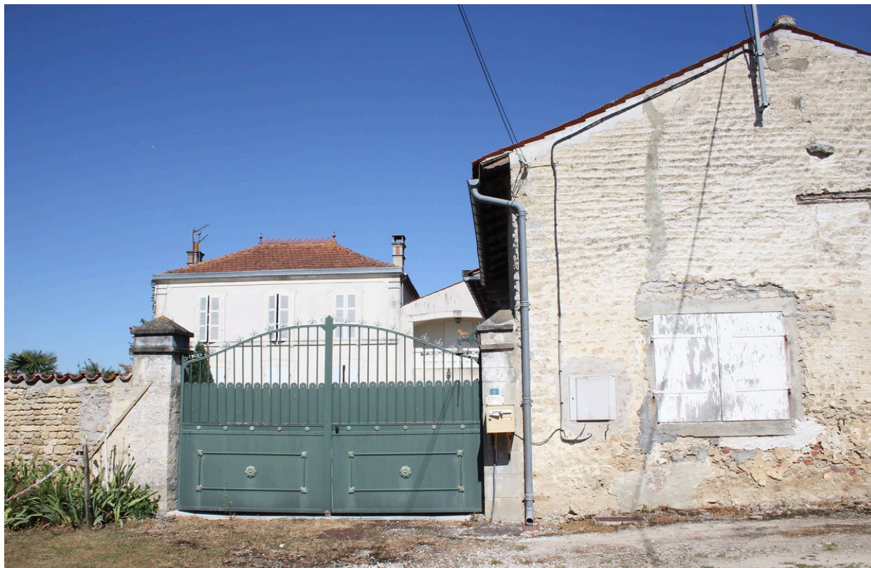
Une vue de l'ancienne ferme, depuis le sud-est.
