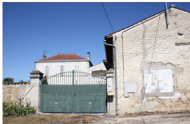
Une vue de l'ancienne ferme, depuis le sud-est. Phot. Nathalie Lhuissier IVR75_20191701994NUCA
