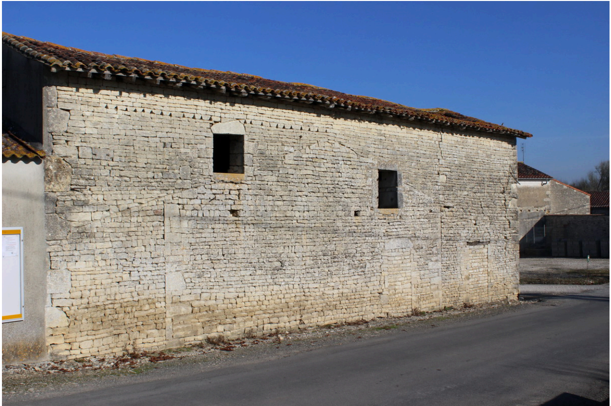
La façade sur rue des dépendances, depuis le sud-ouest.
