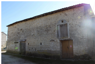
La façade arrière des dépendances, depuis le nord-ouest. Phot. Nathalie Lhuissier IVR54_20171700322NUCA
