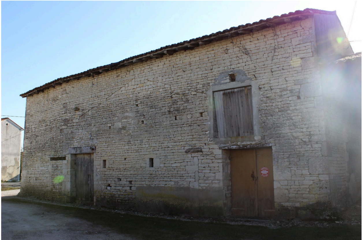
La façade arrière des dépendances, depuis le nord-ouest.
