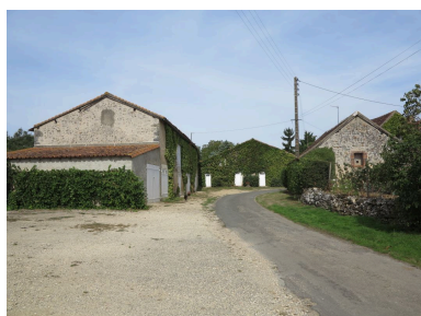
Hameau de La Grange, vu depuis le sud. Phot. Maxime Guichet IVR54_20178601908NUCA
