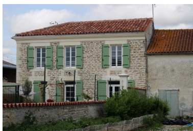
Une vue rapprochée du logement de l'ancienne ferme, depuis le sud.
