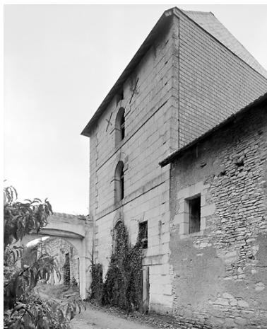
Bâtiment haut, en pierre de taille, façade ouest Phot. Marc Deneyer IVR54_19928601073V
