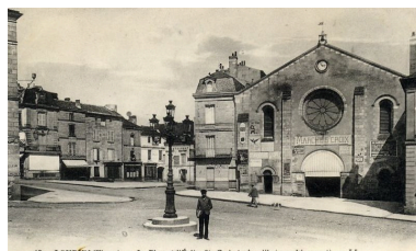
Façade occidentale, carte postale ancienne du début du 20e siècle. Phot. Véronique (reproduction) Dujardin, Autr. L. L. (éditeur) IVR54_20108602048NUC
