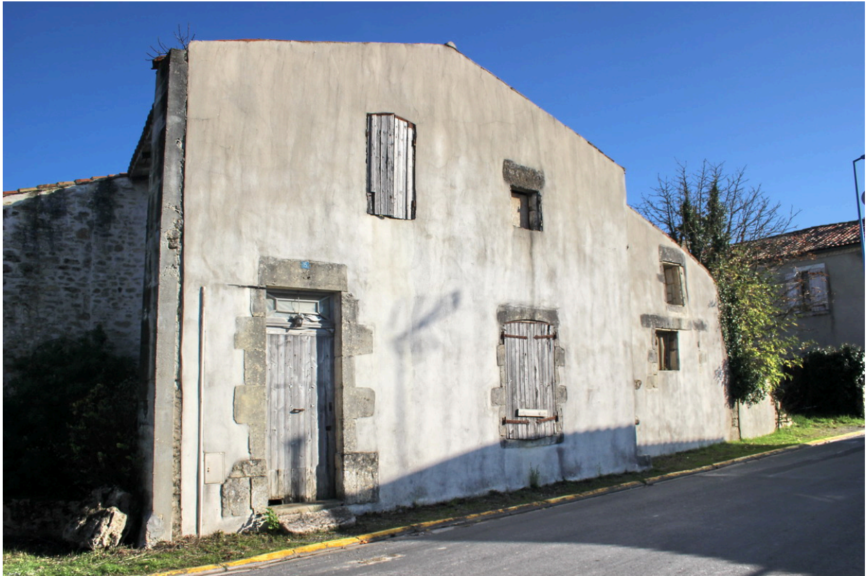
Le logement de l'ancienne ferme et la dépendance accolée, depuis le nord-ouest.
