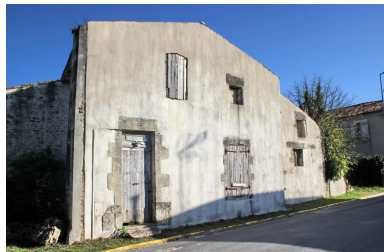
Le logement de l'ancienne ferme et la dépendance accolée, depuis le nord-ouest. Phot. Nathalie Lhuissier IVR75_20191701659NUCA
