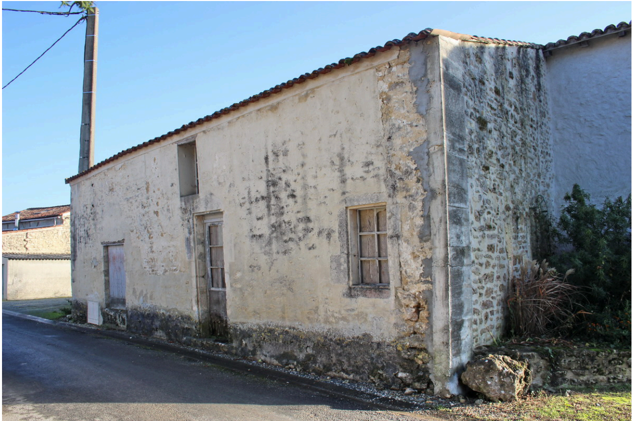
La dépendance située sur la rue de Chepniers, depuis le nord-ouest.
