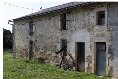
Des ouvertures d'anciens logements. Phot. Pierrick Barreau IVR54_20171702100NUCA
