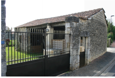
Le hangar, depuis le nord-ouest. Phot. Pierrick Barreau IVR54_20131701320NUCA
