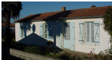
Vue de la façade. Phot. Yann Cussey IVR54_20051702873NUCA
