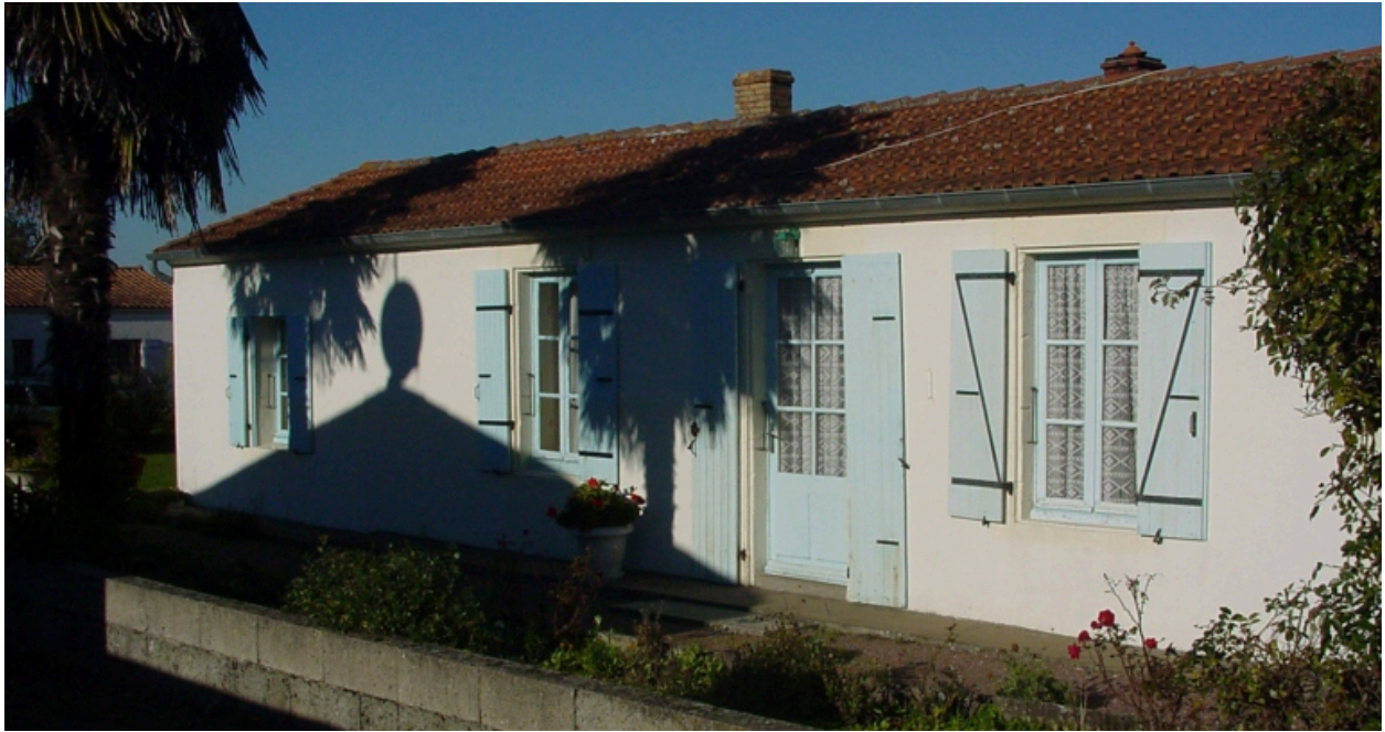
Vue de la façade.
