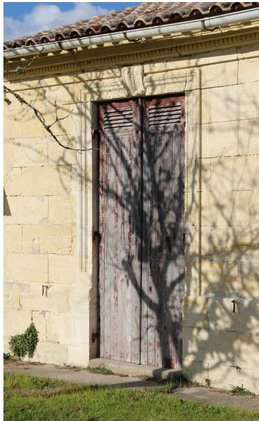
Détail de la porte. Phot. Claire Steimer IVR72_20143304118NUC2A
