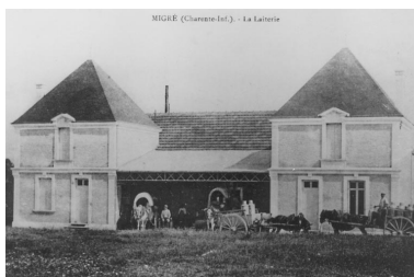
Élévation antérieure avec le quai de réception du lait, carte postale du début du 20e siècle. Phot. Christian Rome IVR54_19971701216X
