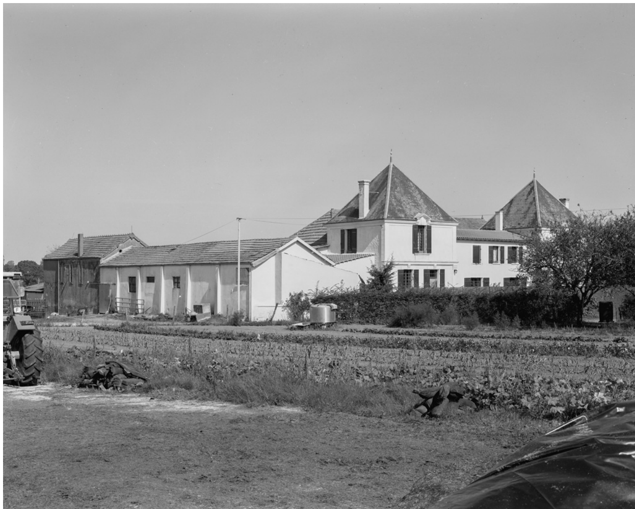
Vue générale prise depuis le sud-ouest, 1997.
