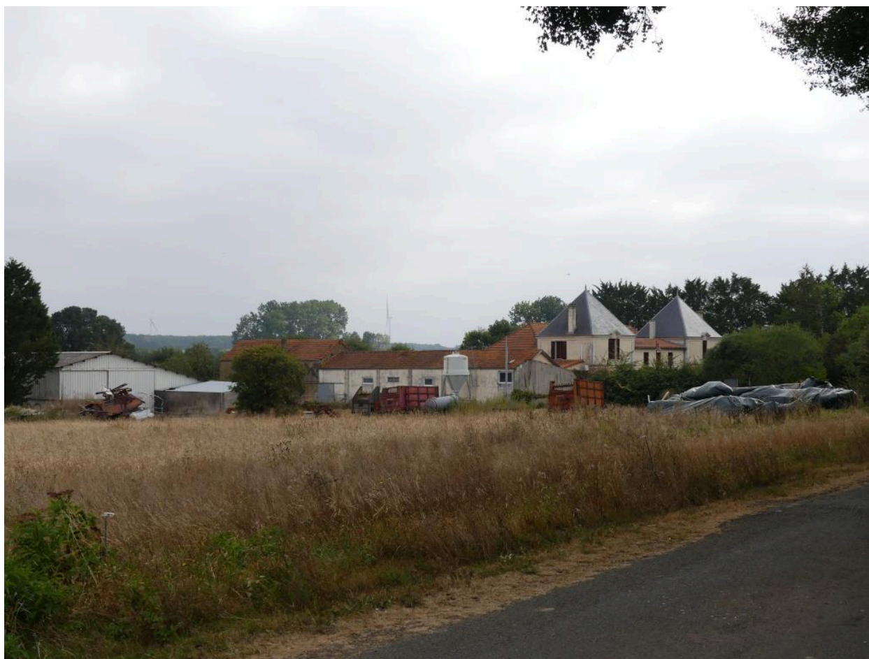
Vue générale prise depuis le sud-ouest.
