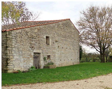
Vue générale de l'agrandissement nord-ouest. Phot. Mathilde Chemin IVR75_20187903274NUCA
