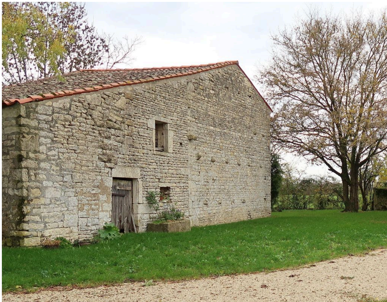
Vue générale de l'agrandissement nord-ouest.
