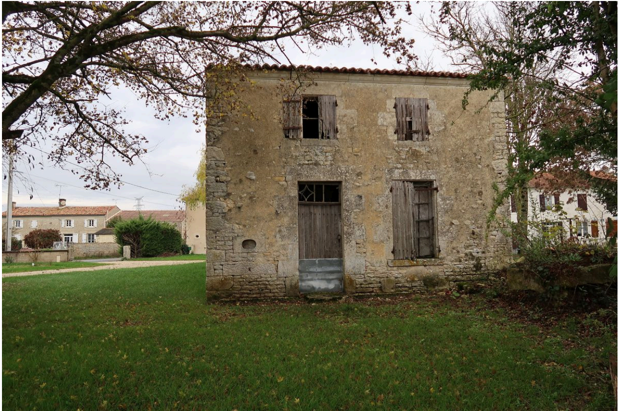
Vue générale de la façade sud.
