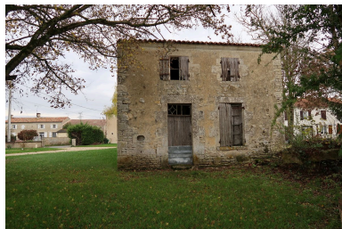
Vue générale de la façade sud. Phot. Mathilde Chemin IVR75_20187903211NUCA
