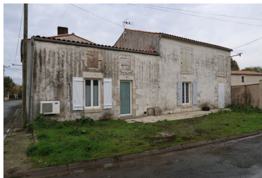
Vue générale depuis la cour au sud. Phot. Mathilde Chemin IVR75_20187903237NUCA
