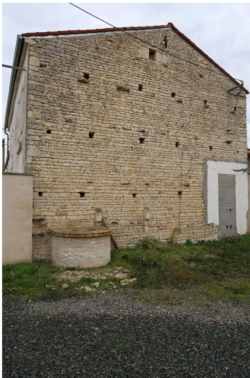
Vue du puits adossé au pignon est.
