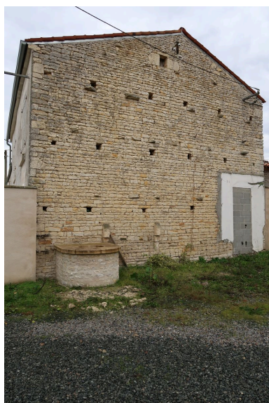
Vue du puits adossé au pignon est. Phot. Mathilde Chemin IVR75_20197902254NUCA
