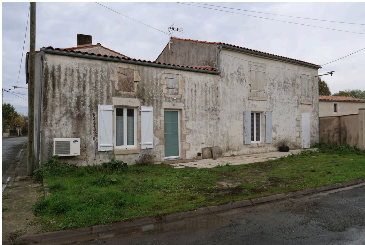
Vue générale depuis la cour au sud.
