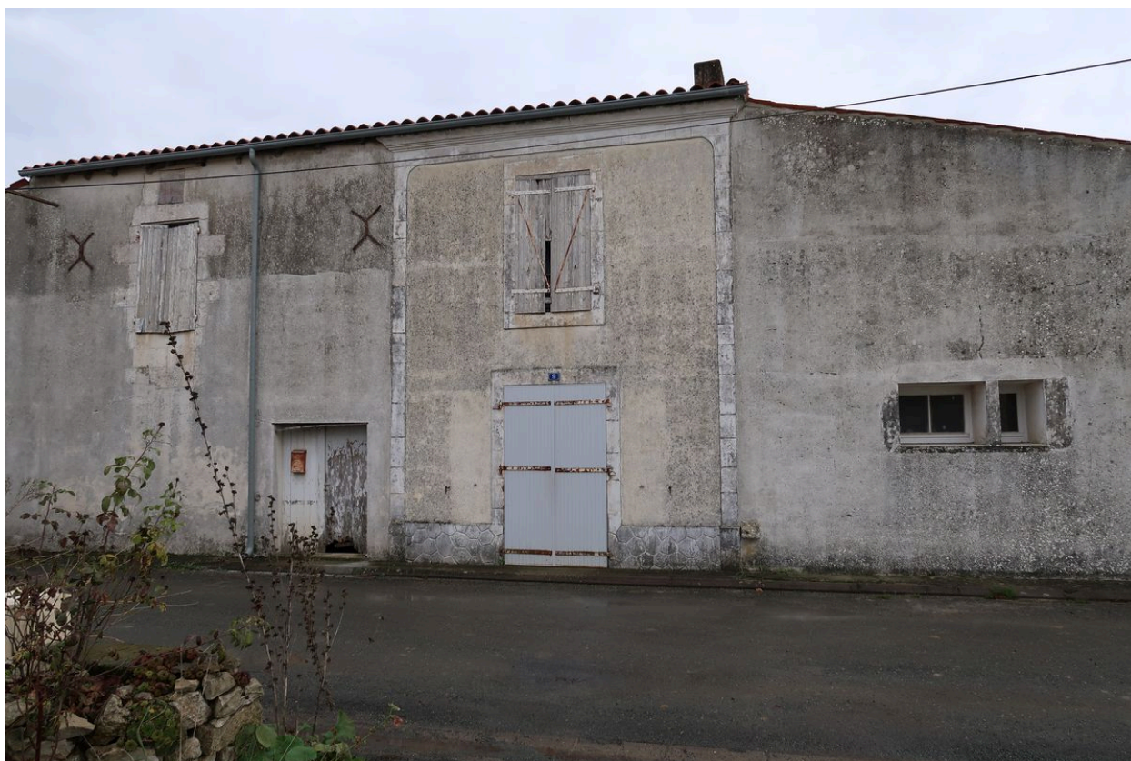
Vue générale depuis la route à l'ouest.
