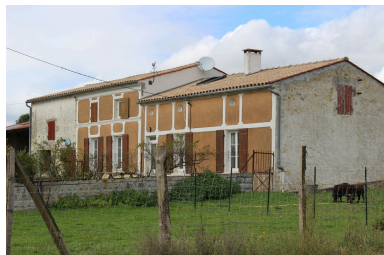
Une vue d'ensemble. Phot. Pierrick Barreau IVR54_20171709803NUCA
