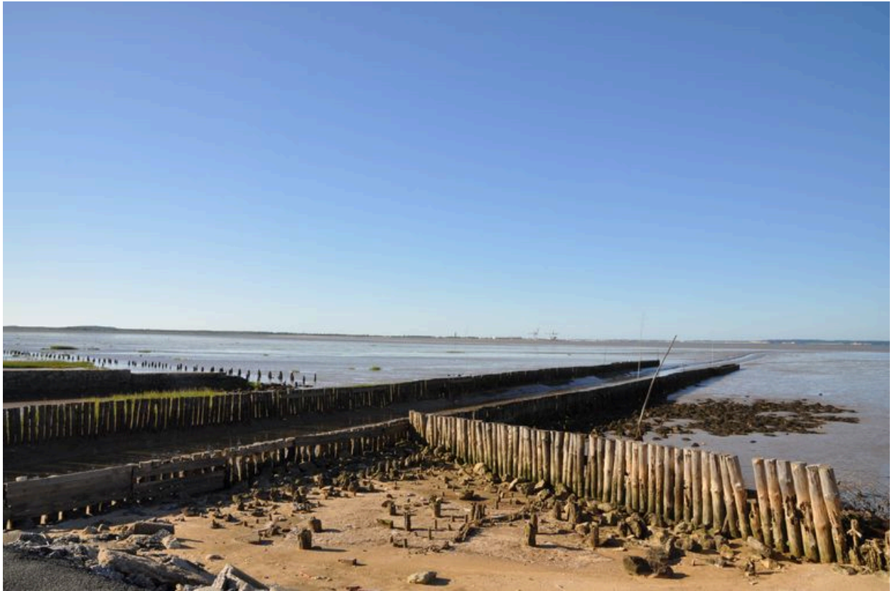
Embouchure du chenal de Talais et présence de pieux pour protéger la rive.
