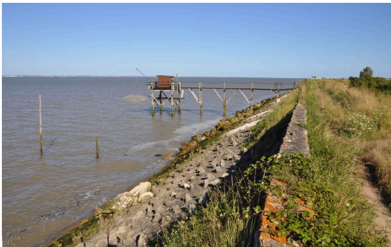
Vue de la digue maçonnée depuis le nord.
