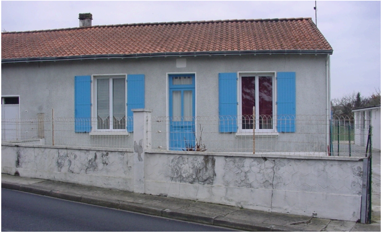
Vue de la maison et de l'opus du mur de clôture.
