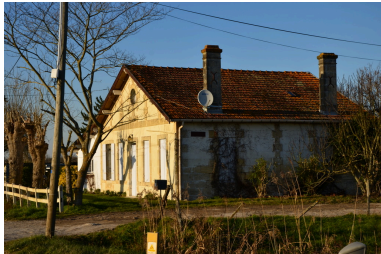
Vue d'ensemble, depuis le sud. Phot. Florian Grollimund IVR72_20153302436NUC2A
