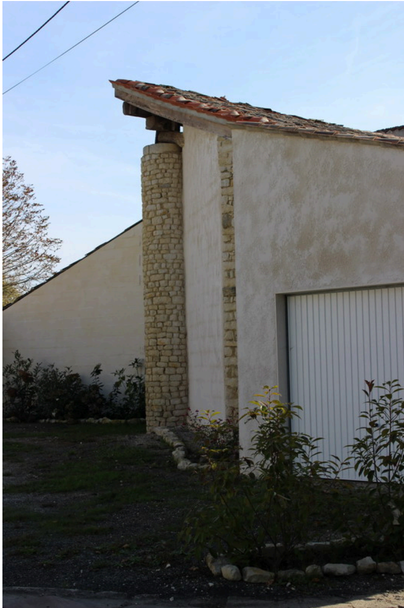
Un détail de la pile maçonnerie du hangar, depuis le nord-ouest.
