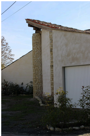
Un détail de la pile maçonnerie du hangar, depuis le nord-ouest. Phot. Nathalie Lhuissier IVR54_20171701486NUCA
