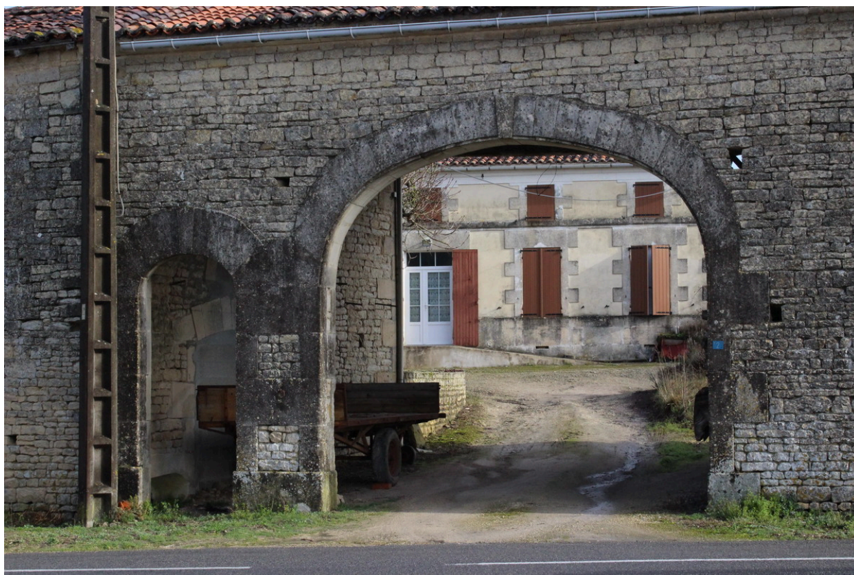
Une vue du passage couvert et du logement de l'ancienne ferme, depuis le sud.
