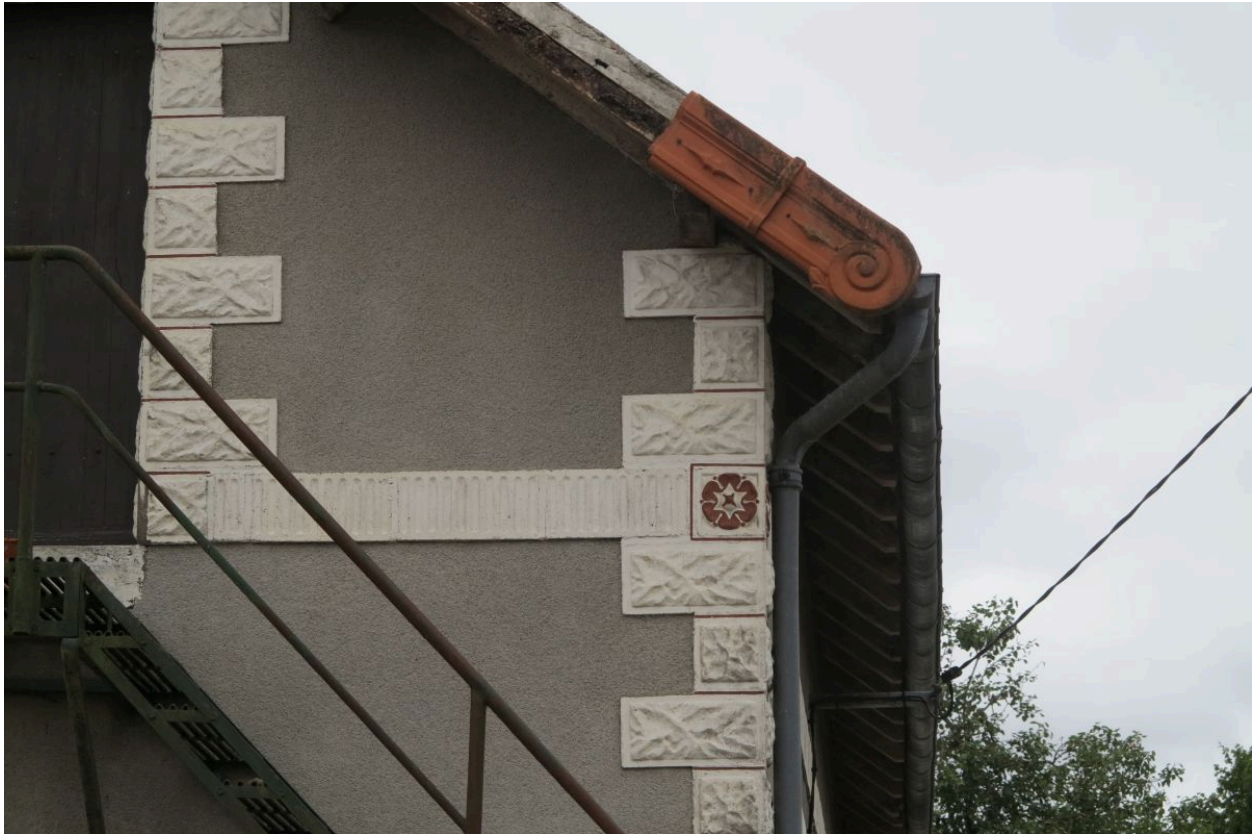
Pignon nord, décor du bandeau supérieur et bossage de la chaîne d'angle et du piédroit droit de la porte.
