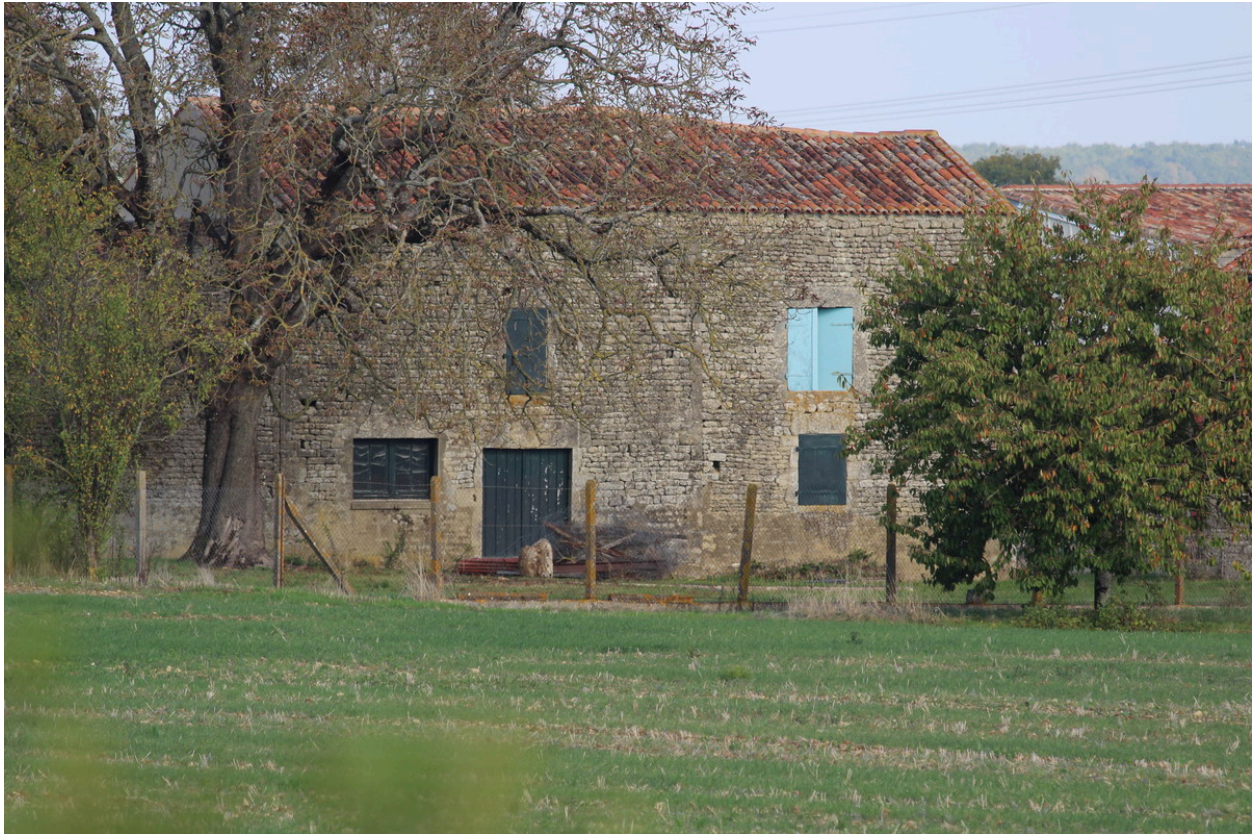
Le corps de dépendances situé sur la gauche, depuis le sud-ouest.
