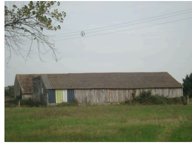
Bâtiments agricoles (façades postérieures). Phot. Jennifer Riberolle IVR72_20123302888NUCA
