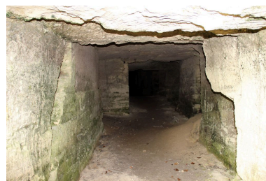
Carrière souterraine sous le coteau d'Eyquem. Phot. Claire Steimer IVR72_20183301248NUC2A
