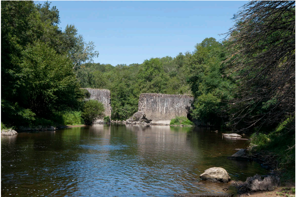
Barrage inachevé dit barrage percé, barrage du Châtelard à Lathus-Saint-Rémy, vu depuis l'amont.
