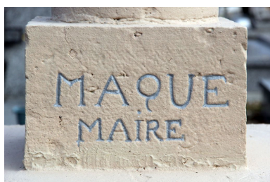
Détail de la base de la colonne : nom du maire Jacques Maque. Phot. Jean-Philippe Maisonnave IVR72_20184002456NUC2A
