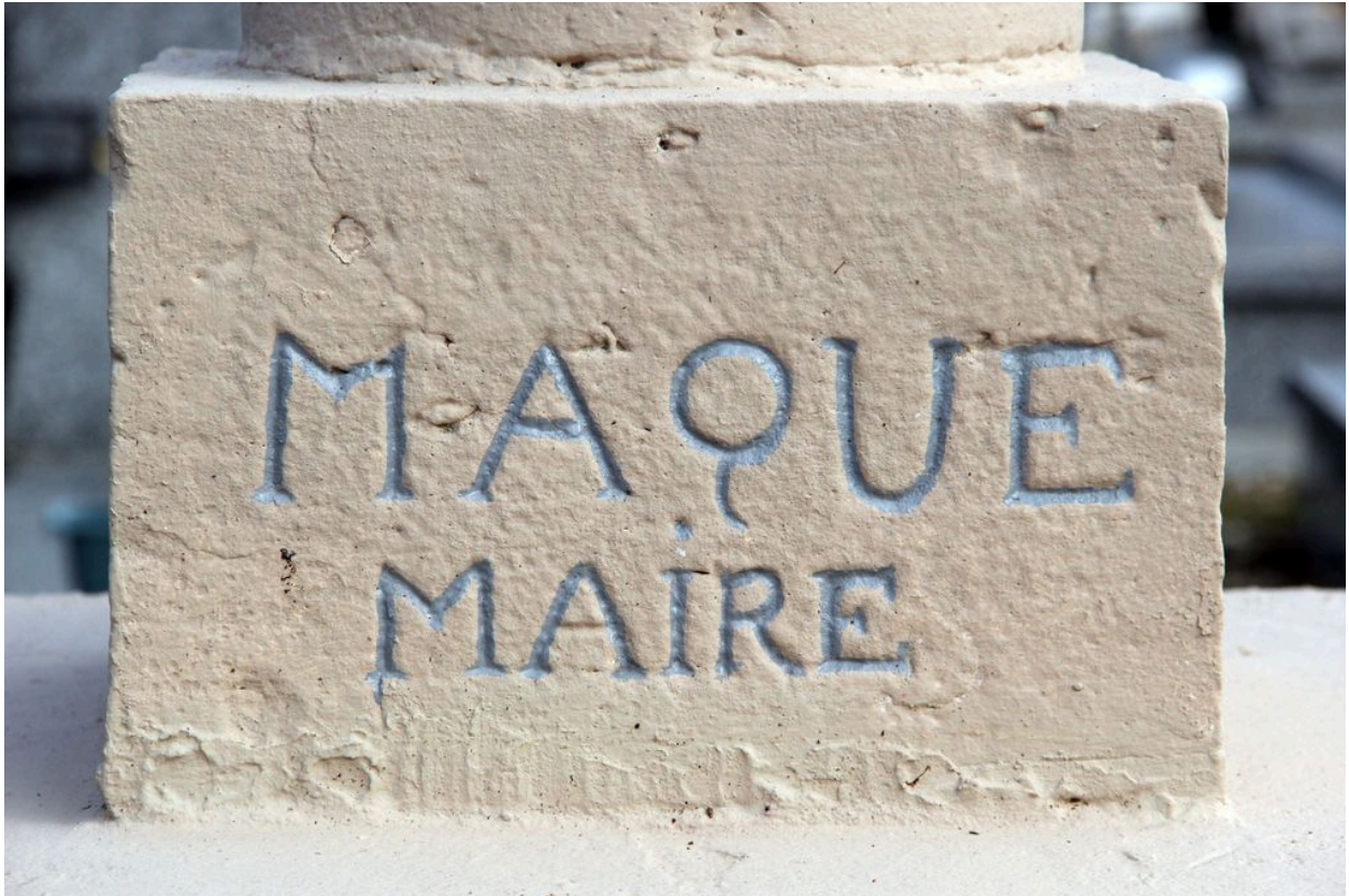
Détail de la base de la colonne : nom du maire Jacques Maque.
