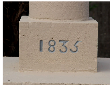
Détail de la base de la colonne : date 1835. Phot. Jean-Philippe Maisonnave IVR72_20184002455NUC2A
