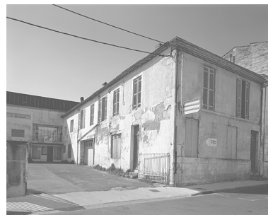
Bureau et logement vus du nord est. Phot. Alain Dagorn IVR54_19991700192V
