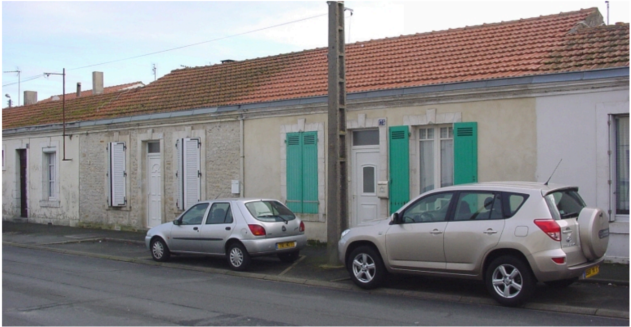
Détail de deux maisons de cet alignement.
