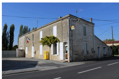
Une vue de la mairie et de la poste, depuis le sud-est. IVR54_20171701465NUCA
