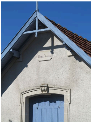
Détail : le pignon et le cartouche portant le nom de la maison. Phot. Yannis Suire IVR54_20131708126NUCA
