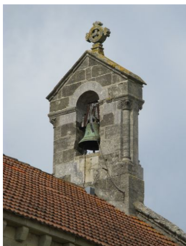
La cloche dans le campanile. Phot. Yannis Suire IVR54_20121705033NUCA
