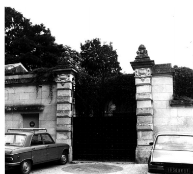
Portail à l'ouest donnant sur le chemin du Rempart. Phot. Dominique Mailles IVR54_19821700599Z
