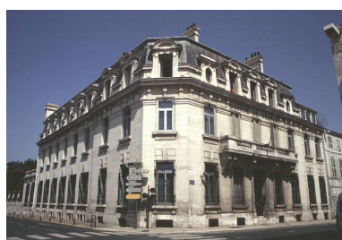
Vue d'ensemble depuis le sud-est. Phot. Alain Dagorn IVR54_20021702277ZA
