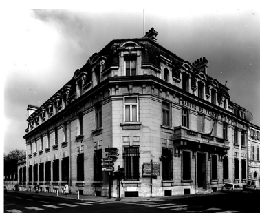
Élévations est et sud sur rue. Phot. Christian Rome IVR54_19961700230V
