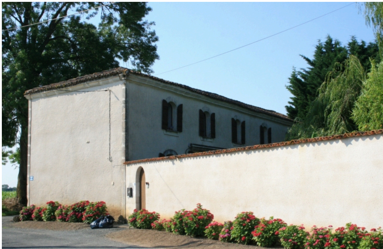
La façade sur cour de la dépendance, depuis le nord-est.
