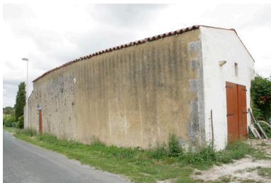
Un bâtiment de dépendances, depuis le sud-ouest. Phot. Cécilia Guiberteau IVR54_20091701626NUCA
