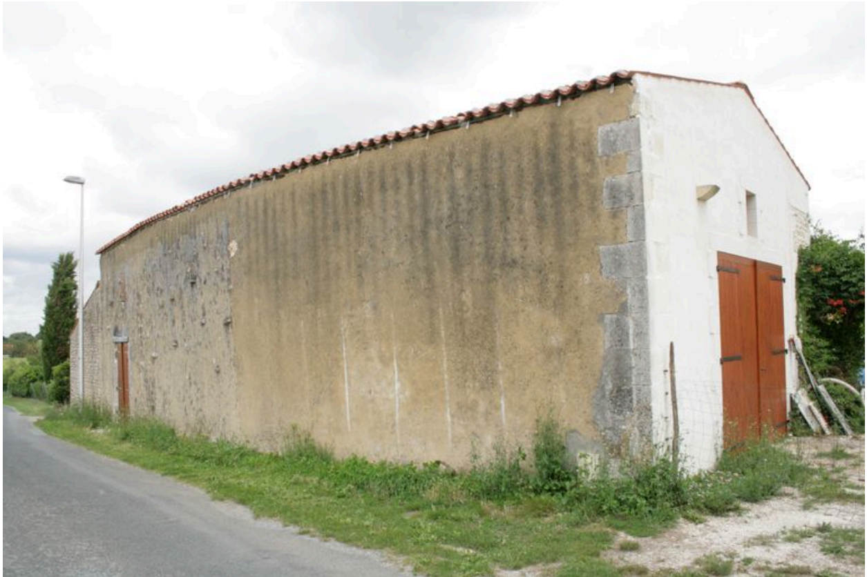
Un bâtiment de dépendances, depuis le sud-ouest.
