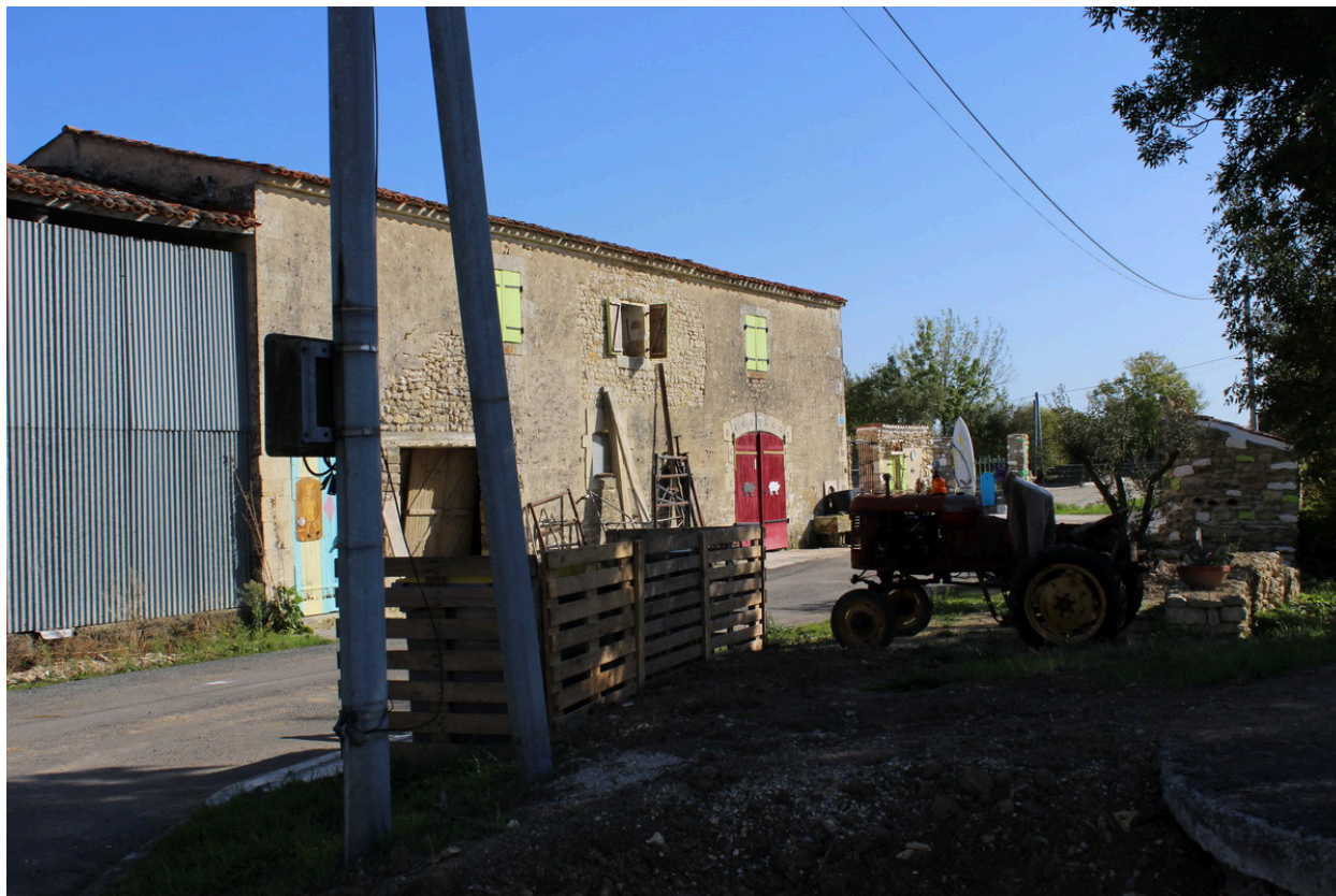
Une vue des dépendances, depuis le nord-ouest.
