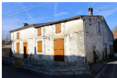
Une vue de l'ancienne ferme, depuis le sud-est. Phot. Nathalie Lhuissier IVR54_20171700027NUCA
