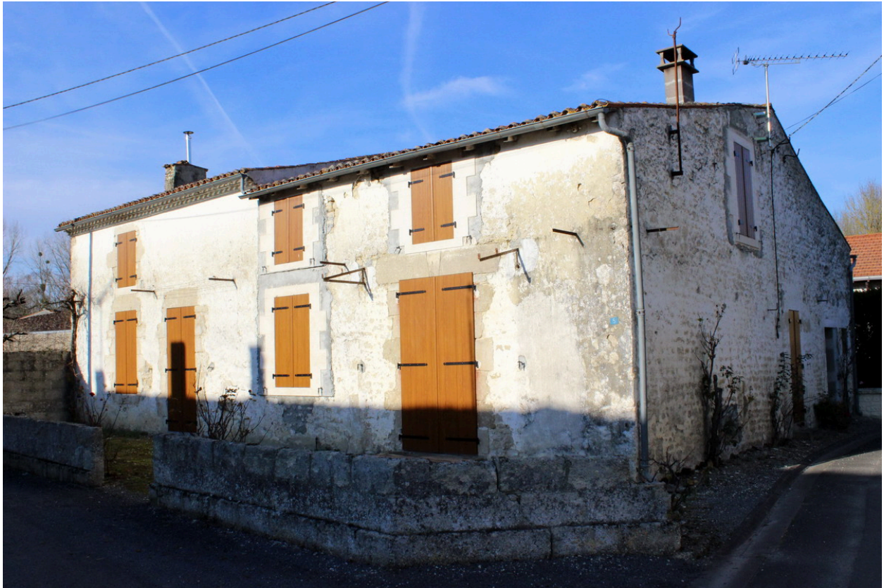
Une vue de l'ancienne ferme, depuis le sud-est.
