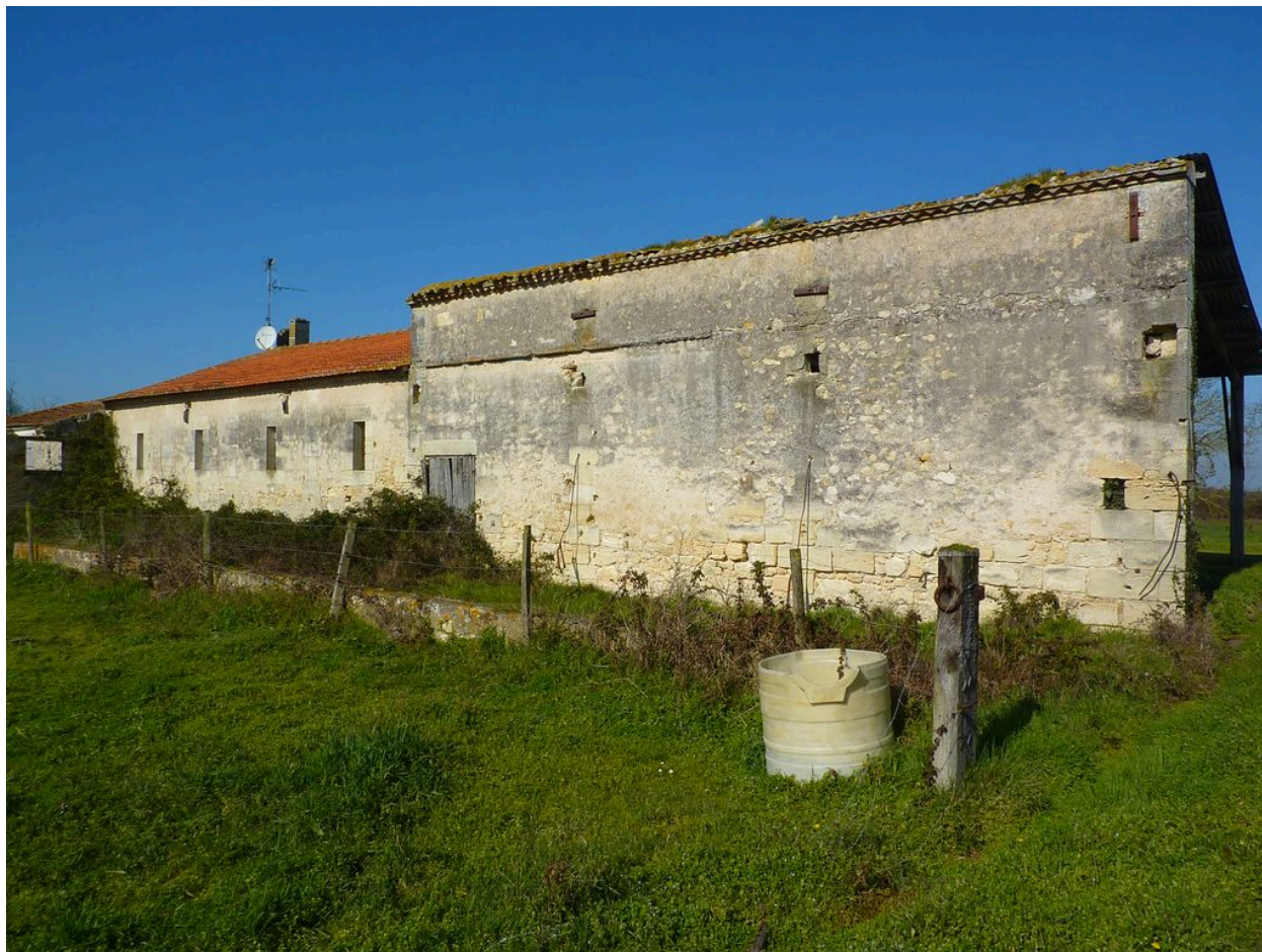
Élévations sud : remise et hangar.
