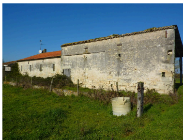
Élévations sud : remise et hangar. Phot. Jennifer Riberolle IVR72_20133300656NUC2A
