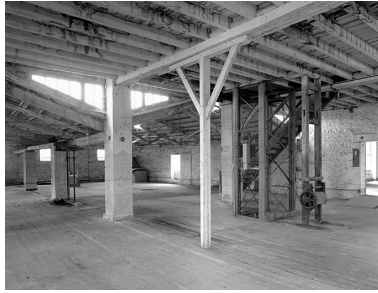
Vue intérieure du premier étage prise du nord-ouest vers le sud-est : mécanisme d'un ancien monte-charge sur la droite. Phot. Marc Deneyer IVR54_20017900097V
