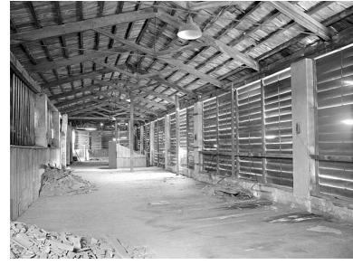
Vue intérieure du séchoir prise du sud vers le nord. Phot. Marc Deneyer IVR54_20017900098V
