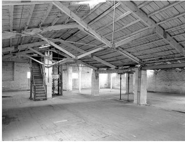
Vue intérieure du premier étage prise de l'est vers l'ouest. Phot. Marc Deneyer IVR54_20017900096V
