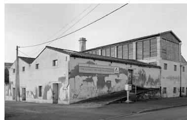
Vue générale prise du nord-est. Phot. Marc Deneyer IVR54_20017900039V
