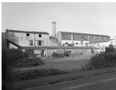
Vue générale prise de l'est. Phot. Marc Deneyer IVR54_20017900038V
