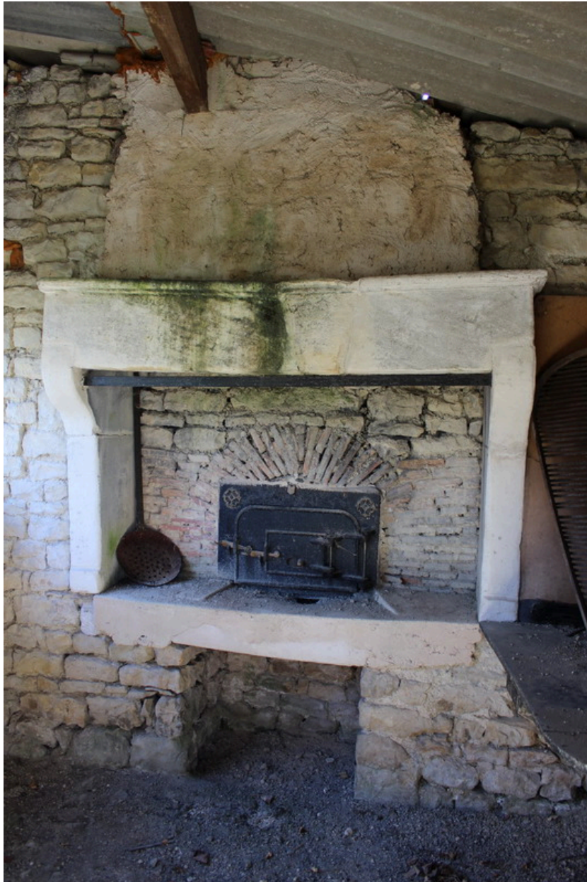
Une vue intérieure du premier four, depuis le nord-est.
