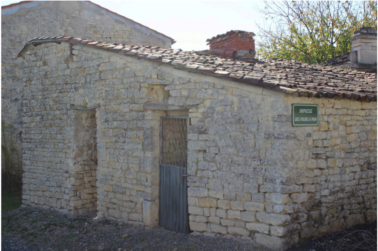
Une vue du premier four, depuis le nord-est
