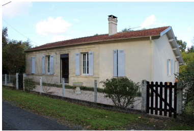
Vue d'ensemble. Phot. Claire Steimer IVR72_20143304114NUC2A
