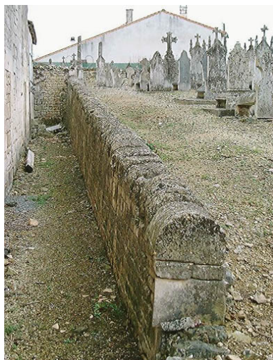
Muret de séparation entre l'église et le cimetière ; à remarquer la réutilisation des tronçons de couvercles de sarcophage en chaperon. Phot. Charlotte Pon IVR54_20027900262NUCA
