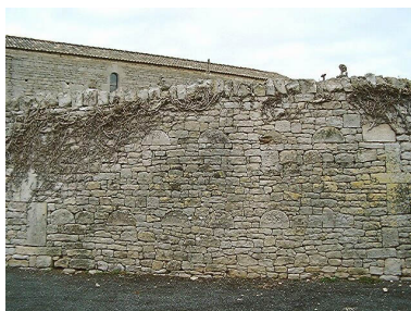
Mur de clôture sud, détail de la mise en oeuvre avec remplois de fragments de couvercles de sarcophages. Phot. Charlotte Pon IVR54_20027900260NUCA
