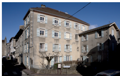
Vue depuis la rue. Phot. Philippe Rivière IVR75_20168700100NUCA
