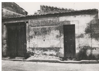
Vue d'ensemble : état en 1974. Phot. Philippe Araguas IVR72_19743301974Z
