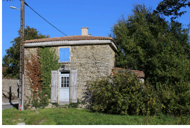
Une vue de la maison, la face ouest, depuis l'ouest. Phot. Nathalie Lhuissier IVR54_20171701482NUCA
