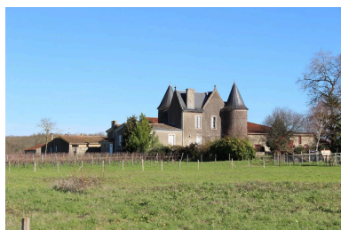
Vue d'ensemble du manoir de La Salle depuis le sud-ouest.
